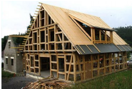
Рисунок 2 - Стеновой каркас или фахверк
